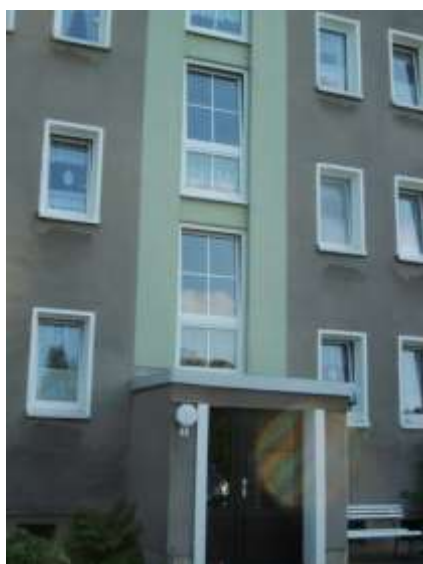
Zrekonštruovaný panelák v Neugersdorfe
